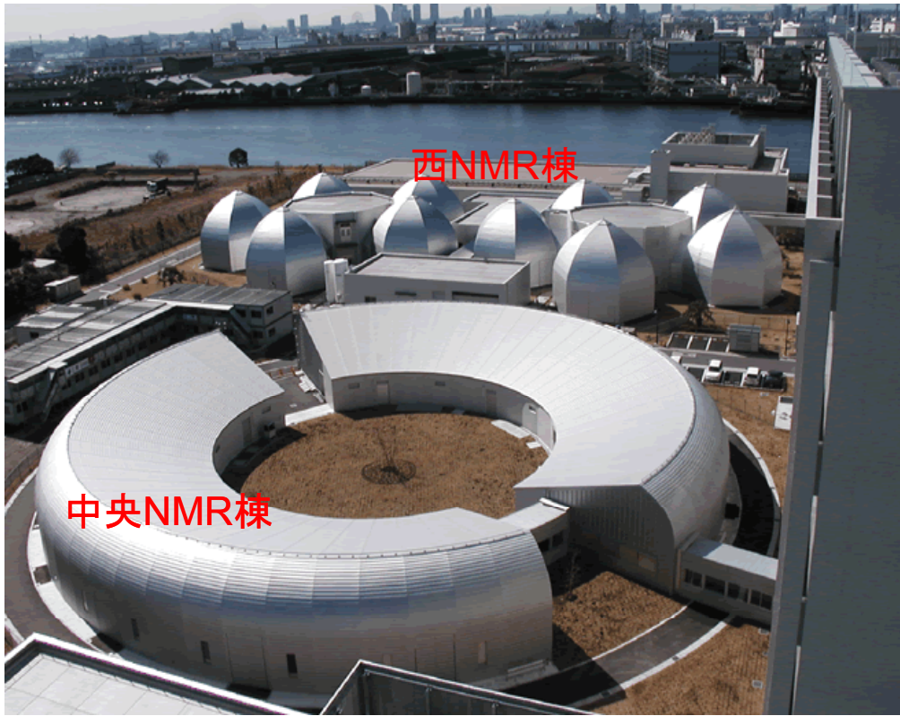
理研横浜研究所NMRパーク NMR棟
